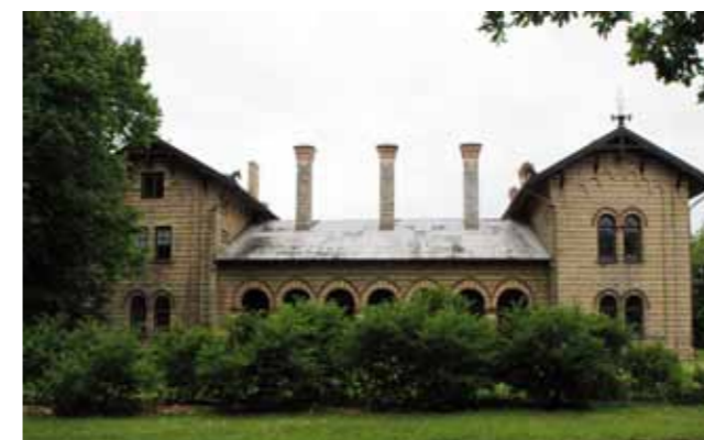
Hovbeslagsskolan. Lågdelen mot Kungsgårdsvägen innehåller smedjan. Flyglarna nu studentbostäder respektive kontor.
