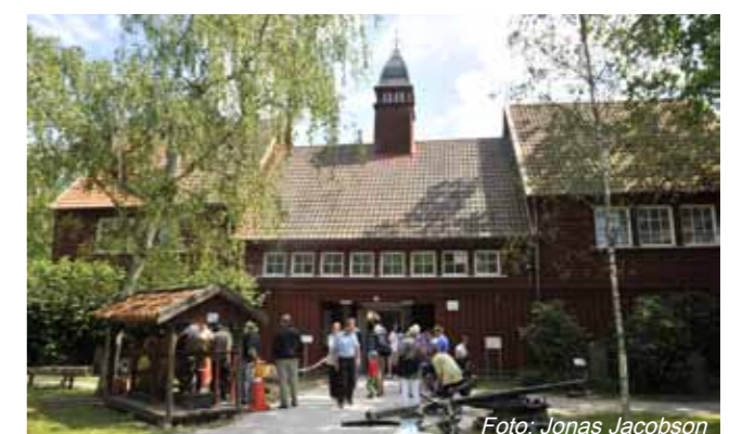
Lantbruksmuseet, invigt 1916. Flyttat från Baltiska utställningen i Malmö. Foto: Jonas Jacobson
