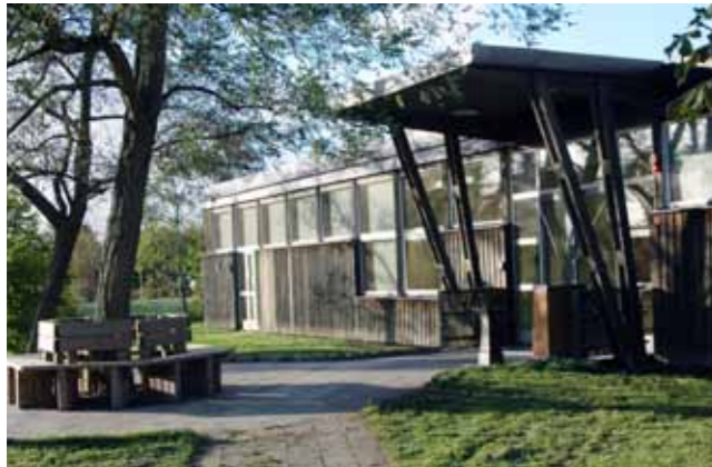
Articum byggt 1974. Ombyggt 2000, inklusive ny entré.
