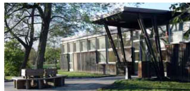
Articum - fick vid ombyggnaden 2000 nytt entréskärmtak.
