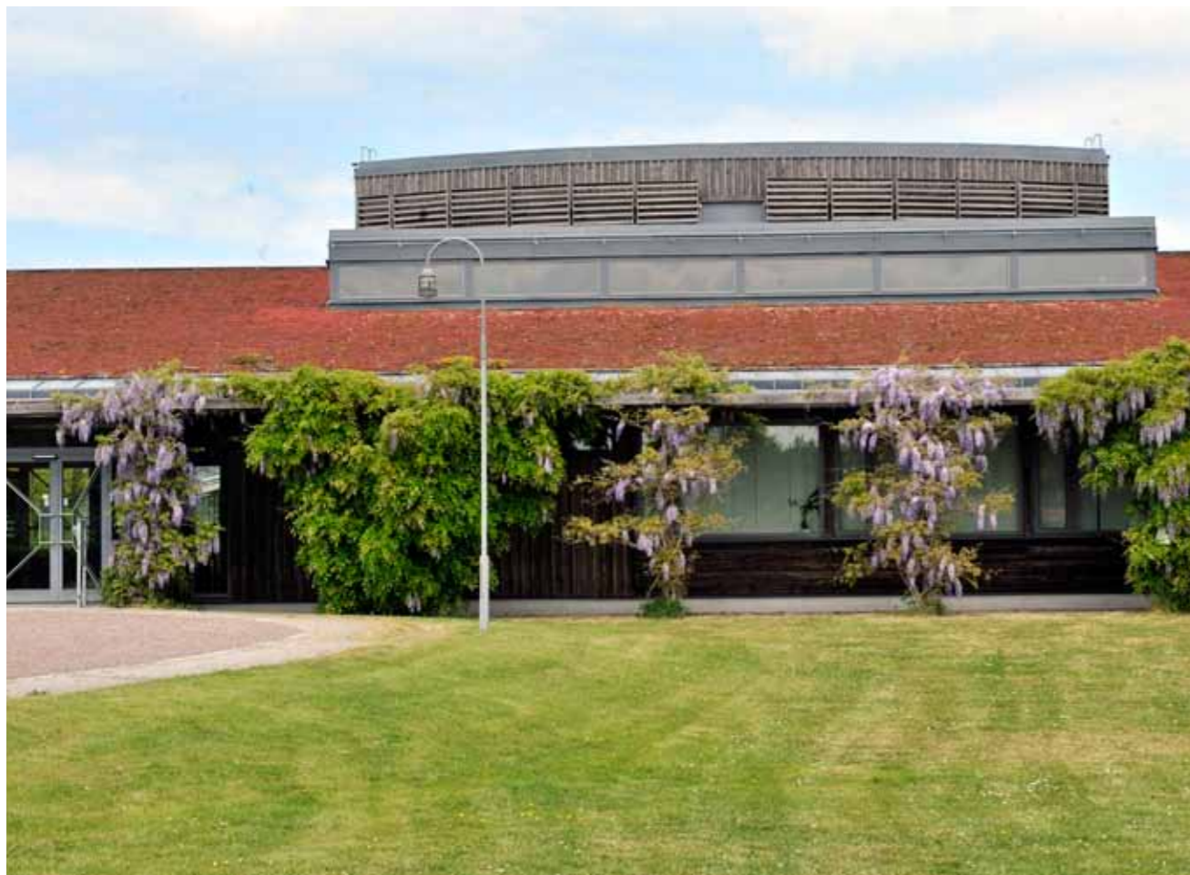
Navet- byggt 2002 med sedumtak och miljöcertifierat trä. Utskjutande takfot med spalje för blåregn (symbolväxt i Alnarp på grund av Slotets praktfulla blåregn) skuggar fönsterpartier. Spaljéer av trä skuggar gavlarnas generösa glaspartier från västersolen.
