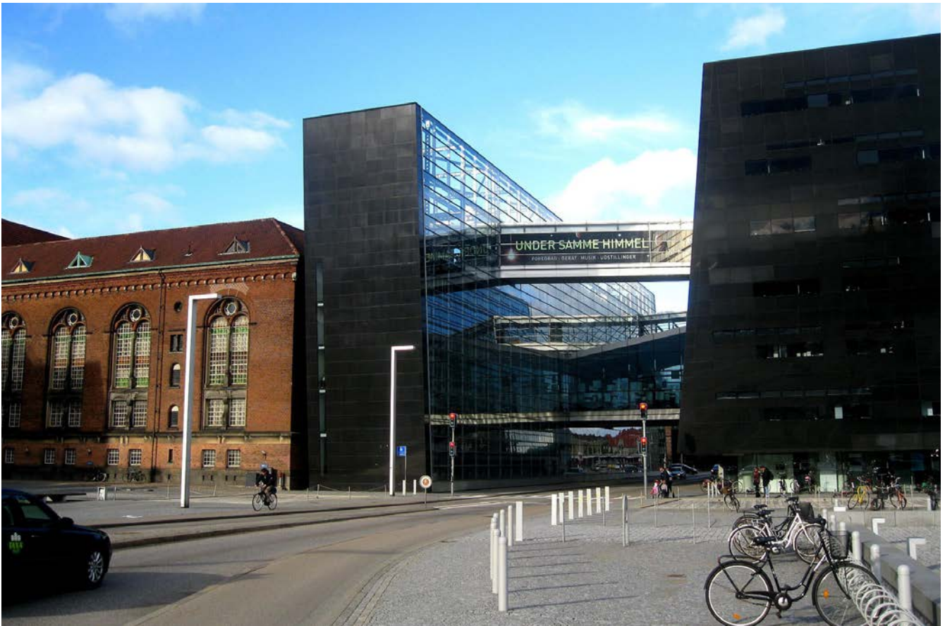
Tillbyggnaden till Det Kongelige Bibliotek i Köpenhamn, även kallad Den Sorte Diamant, är ett exempel på hur en byggnad kan överbygga en trafikerad gata och skapa nya sömlösa samband invändigt.
