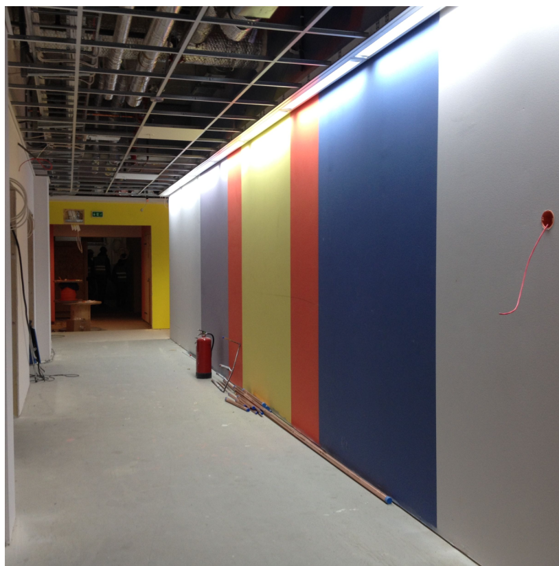
Bild 6. Färgsättning av en korridor under uppförande. (Foto: Lotta Mossum, 2013)
