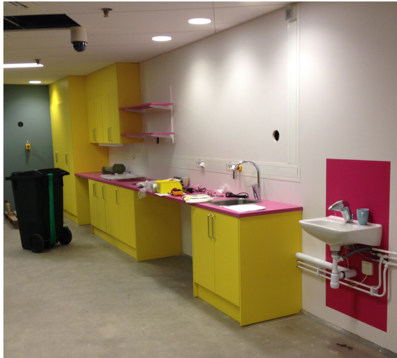
Bild 5. Ett behandlingsrum under uppförande, med detaljrik färgsättning mot en grågrön fond. (Foto: Lotta Mossum, 2013)
