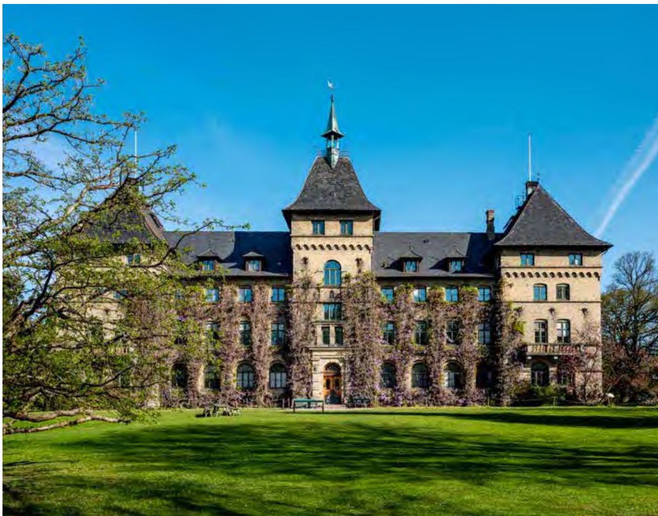
Inom byggnadsminnet Alnarp finns sju numrerade byggnader som berörs av skyddsföreskrifter, varav Alnarps slott är en.
