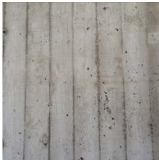
Platsgjuten betong utgör tydligt de bärande elementen.
