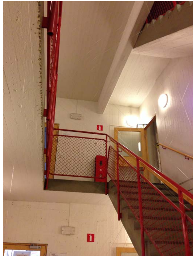
Dörrar i björk mot kontoren ersätts med brandslussar av stål och glas. Dörrar in till kapprum sätts igen. Belysning byts till ny liknande original.
