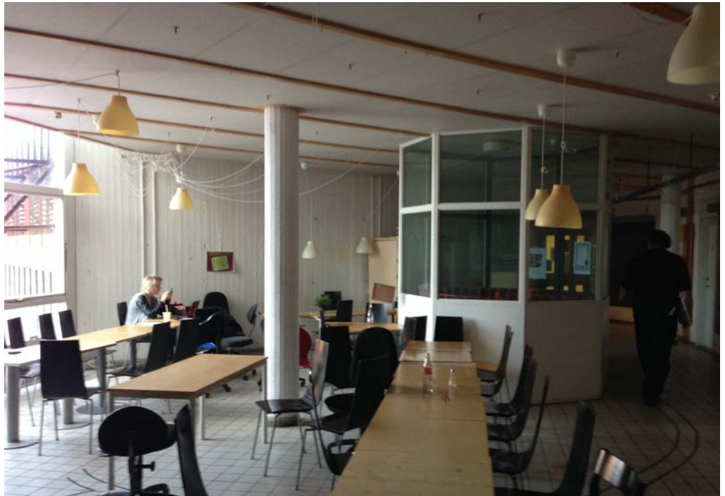
Trappans inbyggnad byts till ny av brandklassat glas. Undertaket rivs för att blotta den rena betongen, likt originalutförande.
