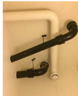
Nakna synliga installationer är genomgående i hela byggnaden.
