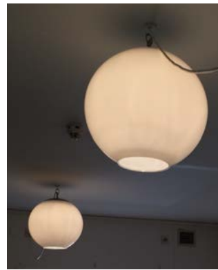
Armaturer i form av pendlade glober i kontorsrum sparas och utrustas med dimmerfunktion..
