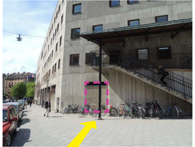
NY ÖPPNING (NÖDUTGÅNG)
