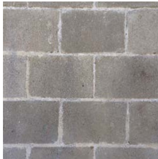
Murad betong i betongsten i utfackningsväggar.
