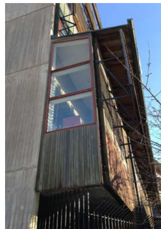
Exteriöra trädetaljer i fasad renoveras och återställs.
