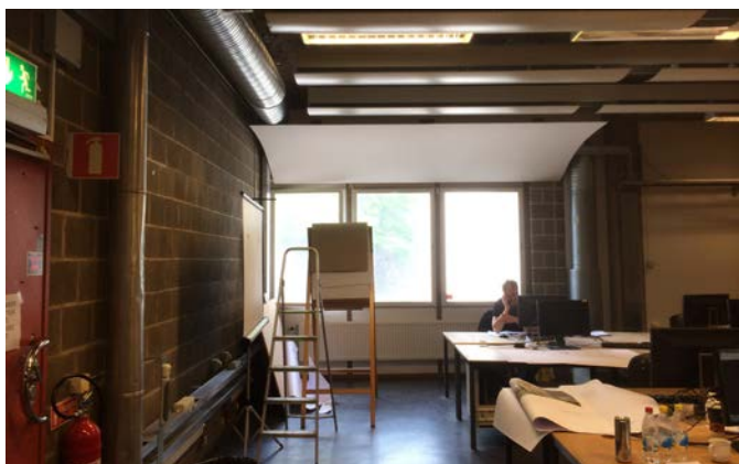
Det enda befintliga ljusinsläppet i lokalen.
