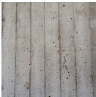
Platsgjuten betong är lämnad synlig även interiört.
