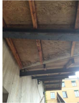
Skärmtak renoveras och bevaras i största möjliga mån. Rost på bärverk slipas bort på plats och stål målas, trämaterial slipas och betsas om likt original. Koppertaket ovan bör försöka behållas.
