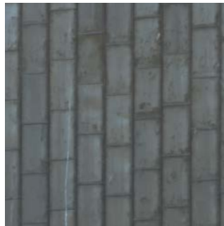
Obehandlad kopparplåt klär fasaderna mot Uggelviksgatan, samt alla byggnadens tak.
