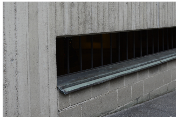
Fönsterbrädor i ärgad koppar renoveras och bevaras.
