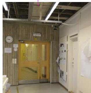
Dörrar till trapphus tas bort och ersätts av nya slussar i glas och stål.
