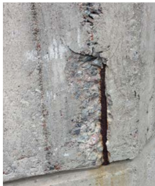
Betongsador på flera platser i fasaden renoveras.
