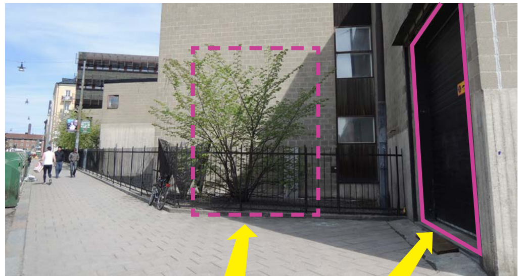
En ny entré till plan 2 och A House tas upp i utfackningsvägg.
