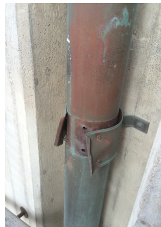
Plåtdelaljer lagas och renoveras.
