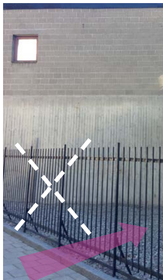
Staket tas bort, platsen innanför öppnas upp och blir en del av trottoaren.
