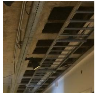
Installationer i tak byts ut och läggs synliga lika idag.
