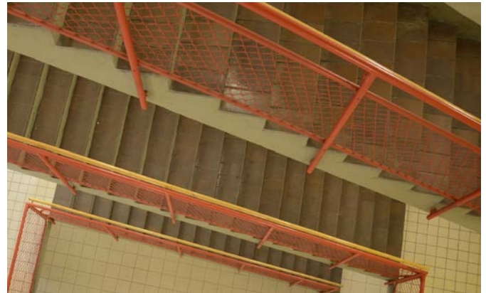
Räckena i stål tmålas om, träräcken renoveras och återmonteras likt idag.
