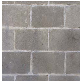
Murad betong i betongsten i vissa inner- och ytterväggar.
