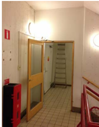
Dörrar tas bort och ersätts med en brandsluss. Wc-paket görs om totalt.
