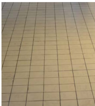
Klinkergolv i trianglarna är original och rengörs och bonas.
