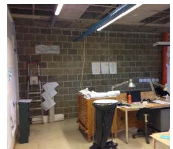
Vissa salar har gavlar av murad betong, vilken lämnas exponerad.
