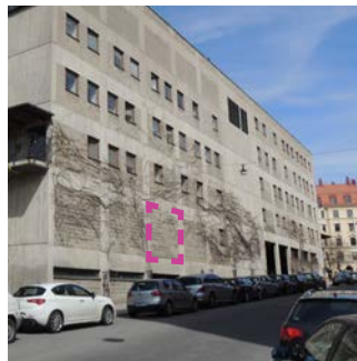
Ett nytt fönster till A House lab tas upp i fasad mot Rådmanngatan.
