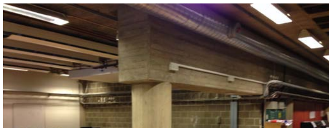
Befintlig struktur och tak bevaras, nya kanaler läggs synliga.
