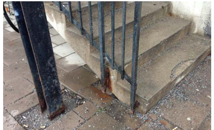
Trappor och räcken renoveras och återställs till ursprunglig gestaltning.
