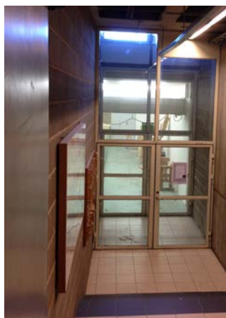
Trappan ner mot restaurangen byggs om, räcket i trä sparas och renoveras om möjligt, annars byts det ut till lika befintligt. Glaspartiet byts ut mot liknande befintligt och målas åter vitt, detta parti står även som referens till övriga nya glaspartier.
