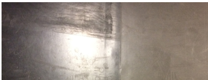
Befintligt linoleumgolv har lappats och byts till nytt.
