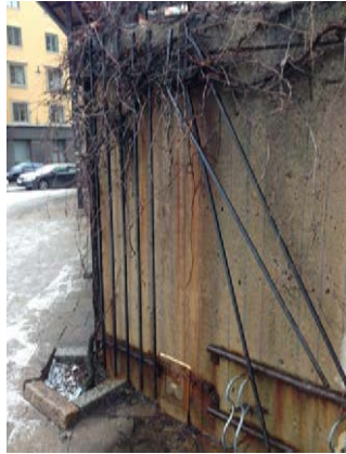
Spaljéer och järndetaljer renoveras. Bakomliggande betong återställs.
