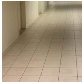
Klinkergolv på plan 2 är nylagt med större plattor än det ursprungliga klinkret. Detta byts till klinker likt original.
