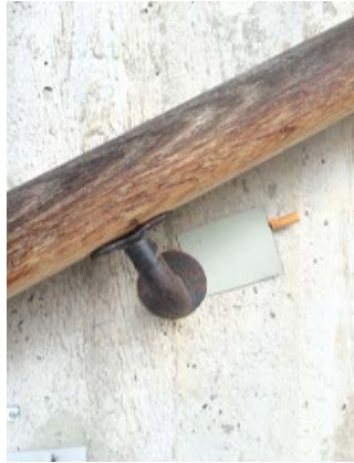
Träräcken renoveras och ytbehandlas. Fästen renoveras eller byts till lika original.
