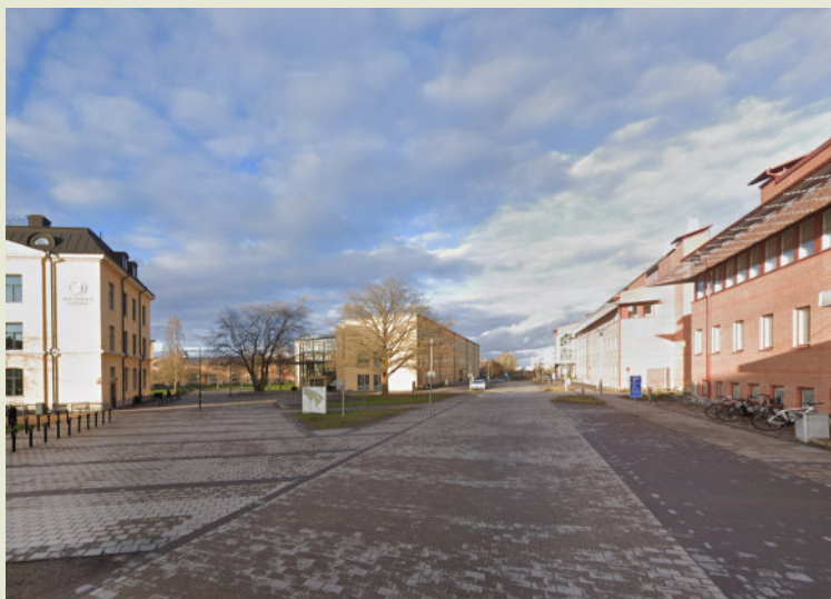
Högslevägen idag. Bilden visar den centrala entrépunkten idag. Kanslihuset till vänster, Hus G rakt fram och Hus E och Hus D till höger.
